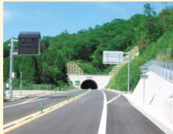
北ノ原トンネル
