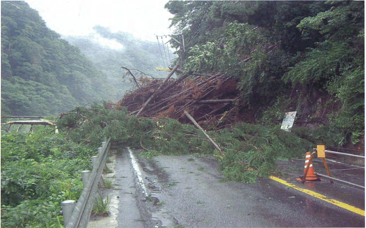
土砂崩落時の状況
