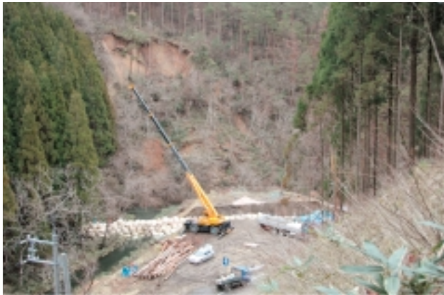
〔仮設水路開削作業〕
