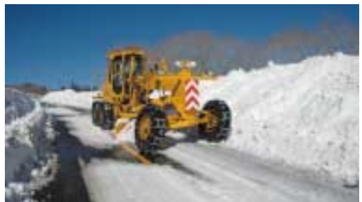
除雪グレーダーによる圧雪撤去作業
