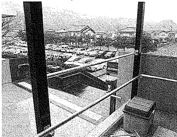
手摺り取付け後
