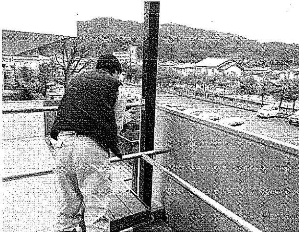
手摺り取付け中
