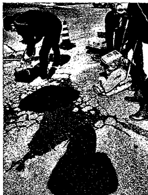
職員による修繕作業（駐車場）
