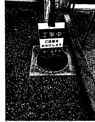
腐食したマンホールの取替え
