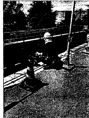
手すりの塗り替え
