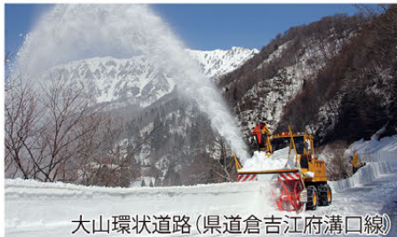
平成29年1月国道373号
