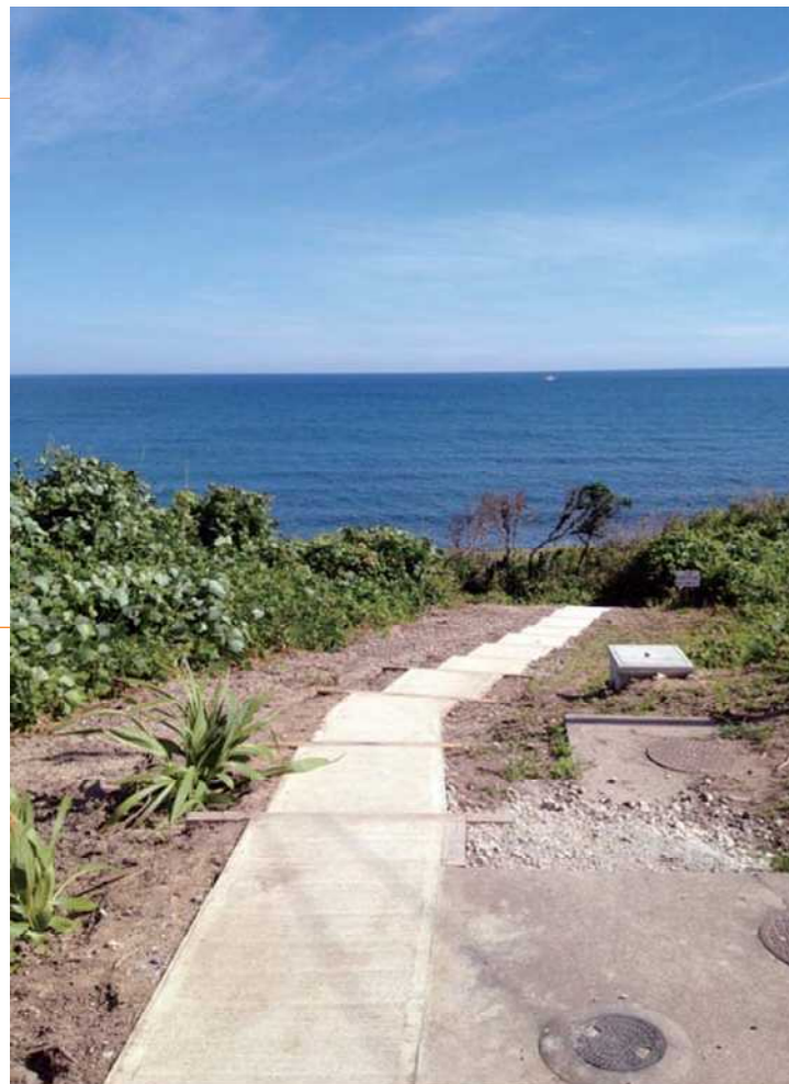
階段やコンクリート舗装を施し、歩きやすくなった浜へのアクセス歩道
