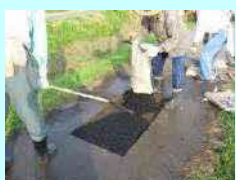
農道の部分補修
