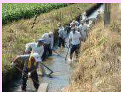
水路の泥上げ
