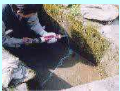
水路のひび割れ補修
