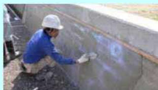
老朽化した水路壁のコーティング
