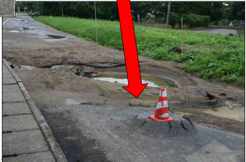
【被害写真：中越沖地震(平成19年)】
