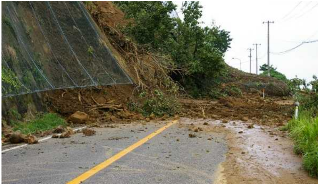
【被害写真：中越沖地震】
