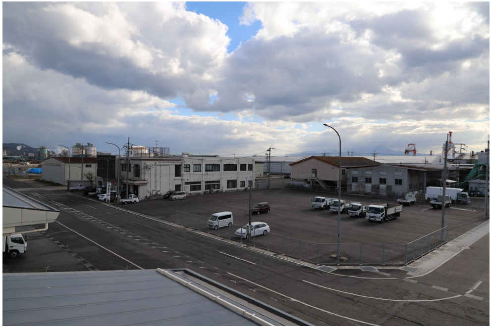
冷凍・冷蔵施設（整備場所）（令和4年12月6日撮影）
