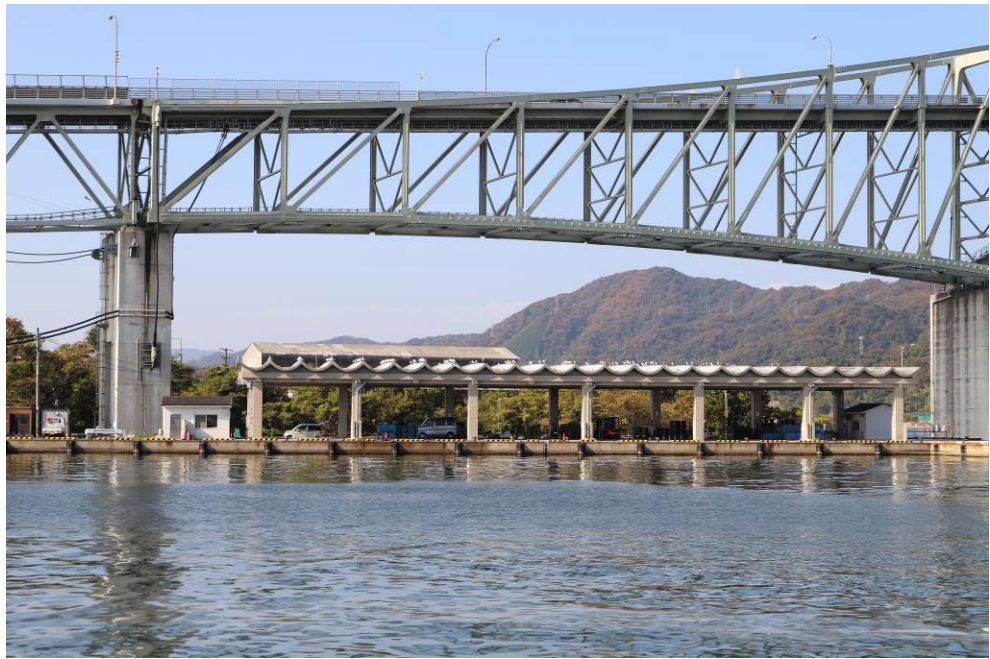
荷さばき所（7号上屋）（令和3年11月18日撮影）
