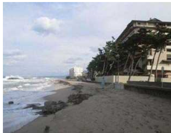
浜崖発生後の状況
