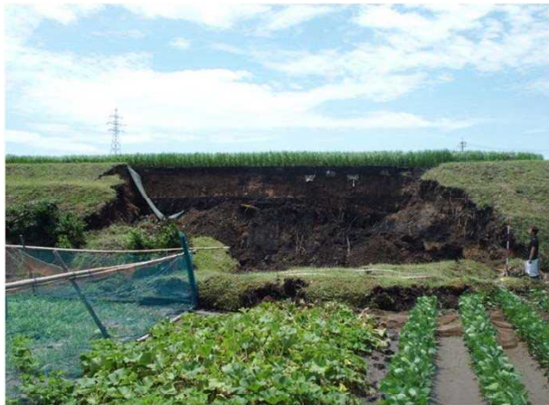
○水田の畦畔が崩壊し、畑に崩壊土が流入 (米子市諏訪)
