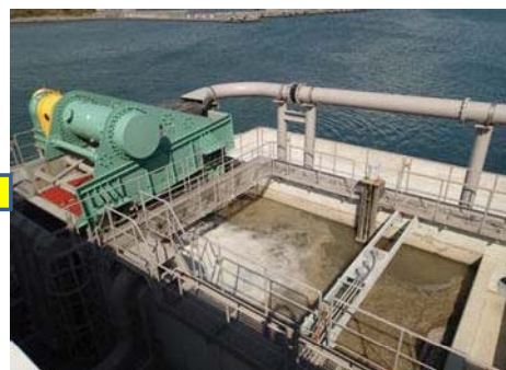
ゴミの除去とスラリーの濃度調整
