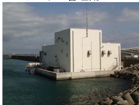
コントロール室兼ポンプ場
