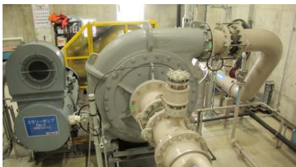
スラリーポンプで圧送
