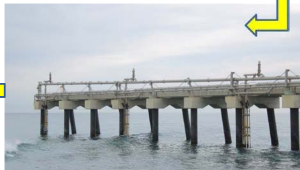
配管にて棧橋へ
