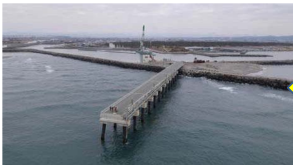
ジェットポンプを固定する棧橋全景
