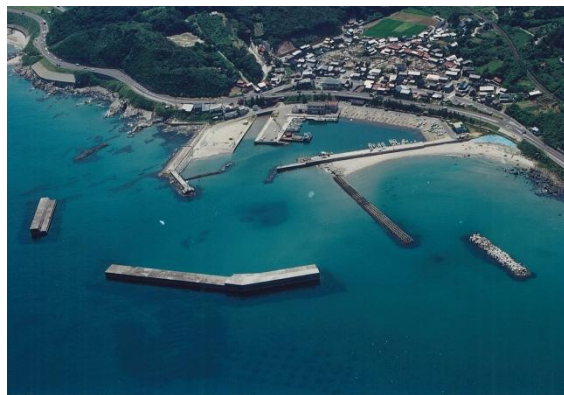
防砂堤未施工
