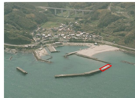
防砂堤(沖部)延伸後 延伸はH18.11月
