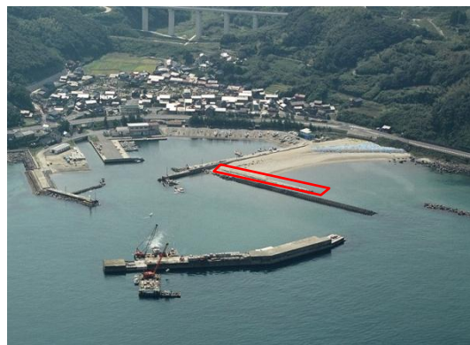
防砂堤(陸上部)完成後 完成はH16.6月
