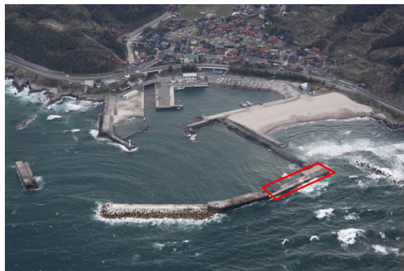
防砂堤(沖部)完成後 完成はH23.1月
