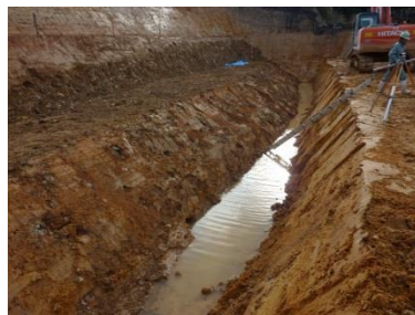
〔掘削状況写真〕
