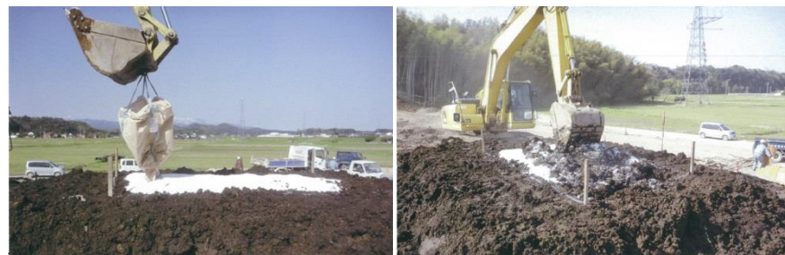
〔改良材混合状況写真〕
