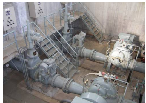
改修された「第 1 揚水機場」
