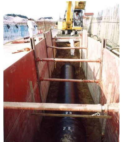
幹線水路の更新工事
