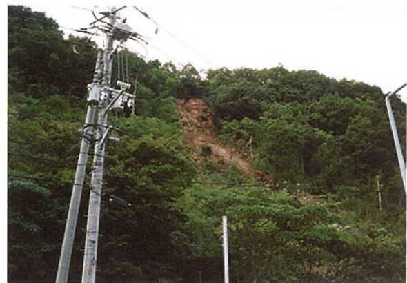
図 17 図 16 の崩壊源頭部の近影 (主要地方道日野溝口線の道路面から約 90m 上方の自然斜面が崩壊した)
