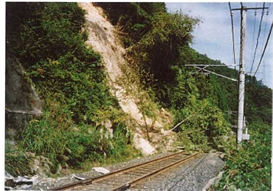
図 7 図 6 の近影（JR伯備線の北側斜面（日野川左岸）が崩壊し、線路を塞ぎ、JR伯備線は全面運休となった）
