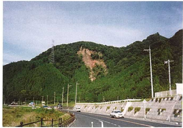
図 19 日野町本郷の自然斜面の崩壊 (柱状節理が発達した玄武岩がトップリング崩壊した)
